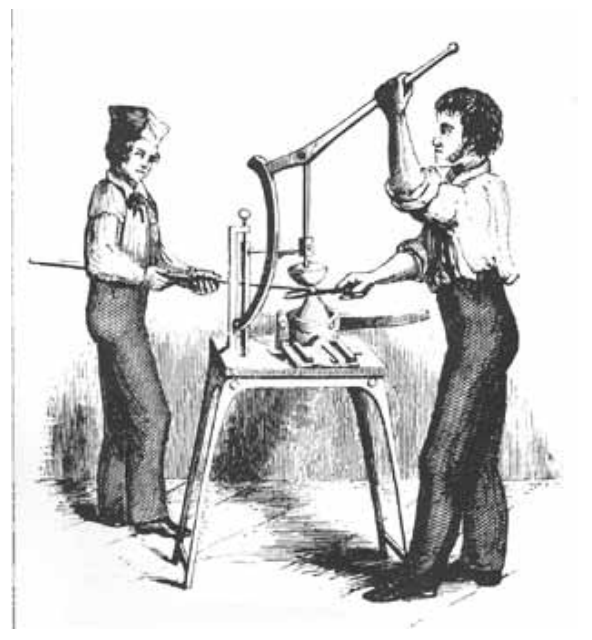
Abb. 2005-1/397 Mechanische Vorrichtung zum Pressen von Hohlgläsern mit dem Stempel aus Apsley Pellatt, Curiosities of Glassmaking, London 1849
