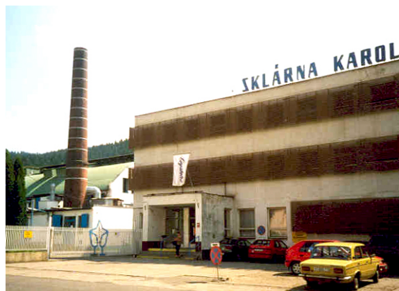
Abb. 2002-4/183 Glaswerk Karolinka, Eingang u. Bürogebäude, August 2002
