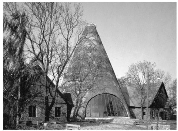
Industrie-archäologische Ausgrabungen im Glaskurm legten 1985 die Grundmauern des letzten Gernheimer Schmelzofens frei. Diese Fundamente bildeten später die Grundlage für die Rekonstruktion des Ofens. 1987 wurde der Schürgang unter dem Turm wieder begehbar gemacht. Seitdem ist die technische Funktion des Glashüttenturms - ein riesiger Kamin, der durch seinen Sog die Frischluft-Zufuhr zum Schmelzofen verstärkte - bei einer Besichtigung wieder gut nachvollziehbar.
