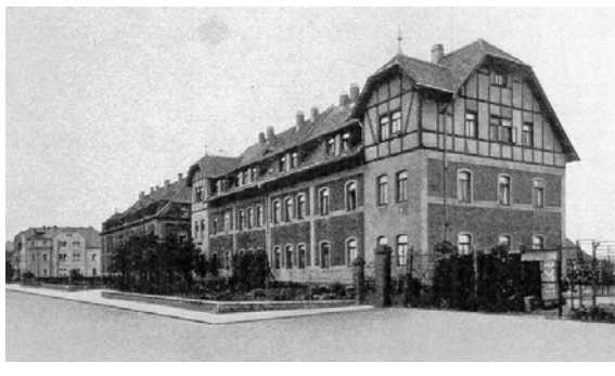
Abb. 04-99/112, Glasfabrik AG Brockwitz 1928, Werkswohnhäuser, aus Brockwitz 1928, S. 37
