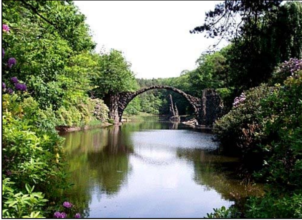
Abb. 2009-4/xxx Rhododendronpark Kromlau, Rahkotzbrücke
