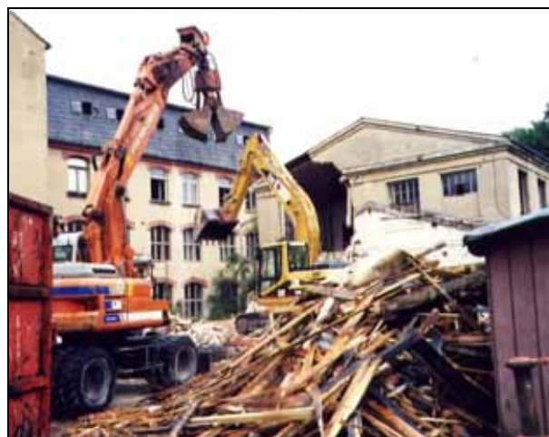
Abb. 2011-1/207 Abriss am Hartglaswerk 1998 Sammlung Reiner Tschackert
