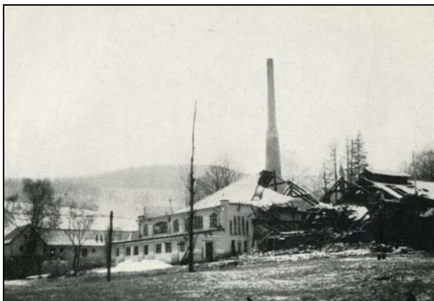
Abb. 3. Glashütte Buchenau östl. Oberzwieselau, 1935 durch Schneedruck zerstört. (Eig. Aufn. 1935)
