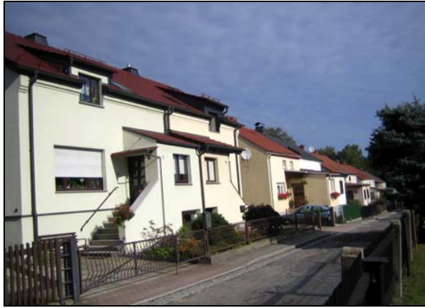
Abb. 2013-1/20-24 1922 erbautes Wohnhaus am Glashüttenweg 2012
