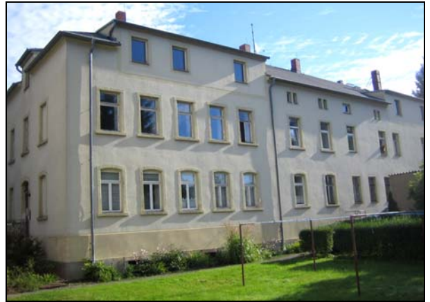
Abb. 2013-1/20-11 ehemalige Malzfabrik 2012, Hofseite
