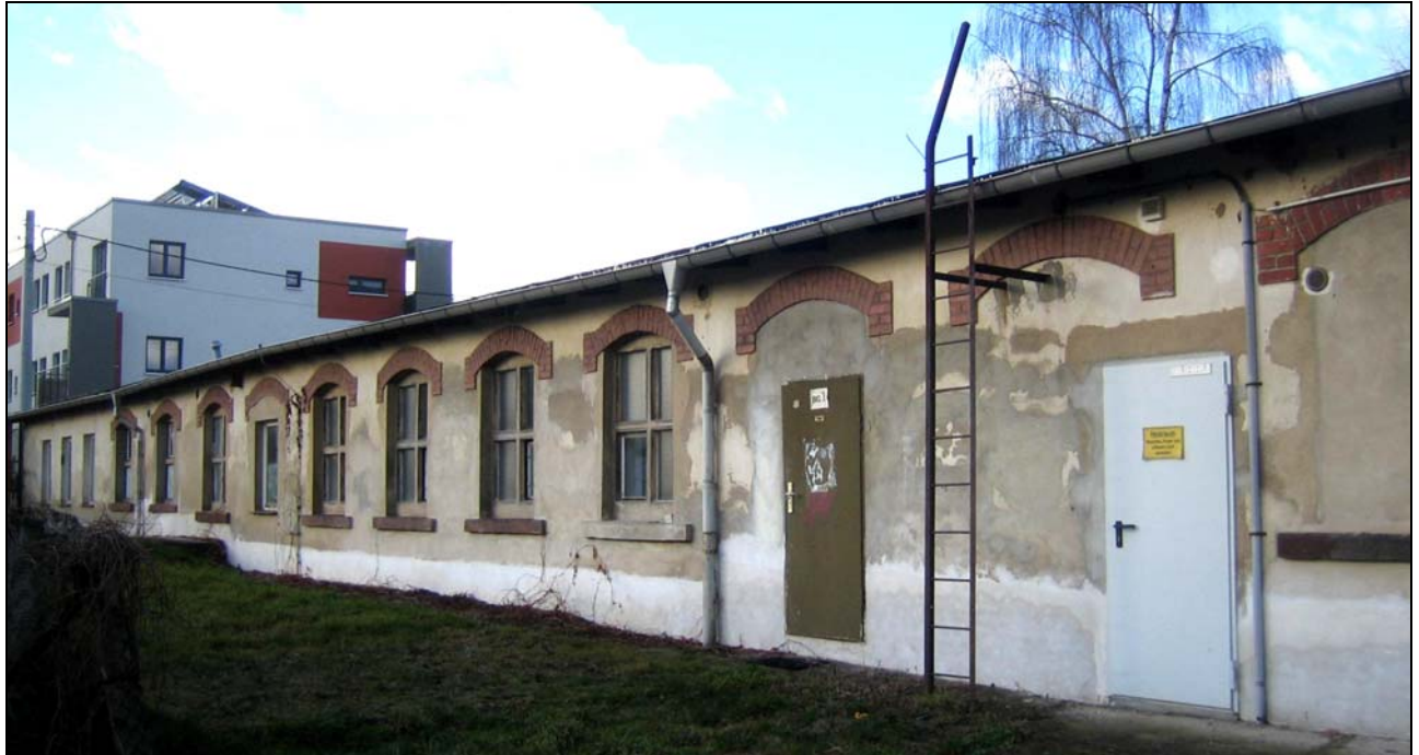
Abb. 2013-2/21-24 Ehemalige Schneid- und Packschuppen (Foto Mauerhoff 2013)
