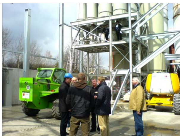
Abb. 2013-4/38-13 GLASAX: Richtfest Gemengehaus am 02.04.2008
