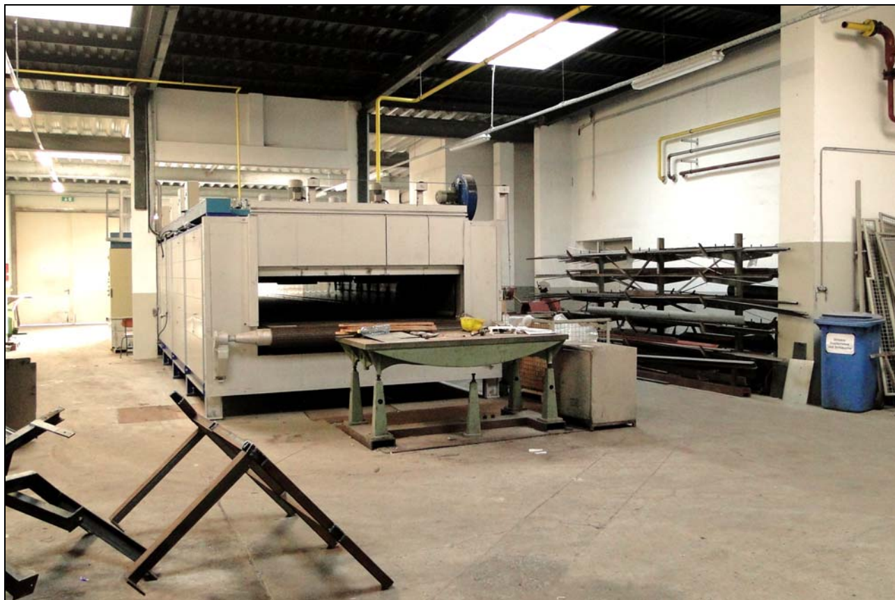
Abb. 2013-4/38-26 und Abb. 2013-4/38-27 GLASAX: Demontage Einbrennbahn; Leereräumte Hüttenhalle
