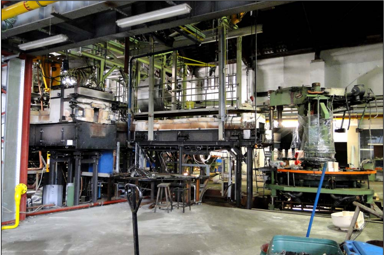
Abb. 2013-4/38-19 und Abb. 2013-4/38-20 GLASAX: Demontage der 10-Station-Waltec-Press; Verladung der Presse
