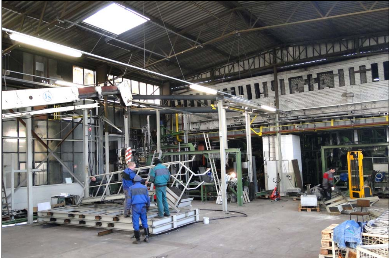
Abb. 2013-4/38-21 GLASAX: Stahlteile werden abgebaut
