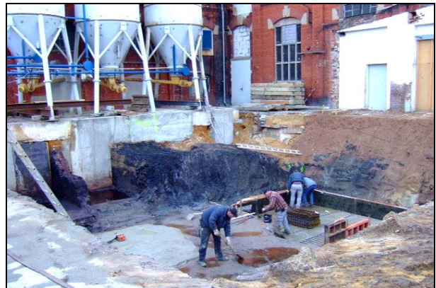
Abb. 2013-4/38-11 GLASAX: Unterbau des neuen Gemengehauses, 2007
