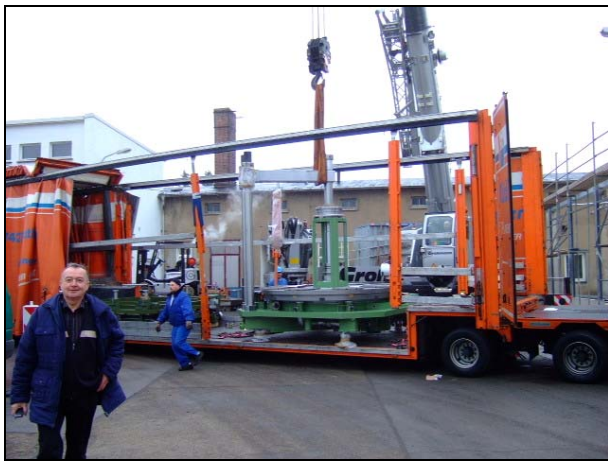
Abb. 2013-4/38-09 GLASAX: Montage der neuen Waltec-Presse (Foto A. Koitzsch)
