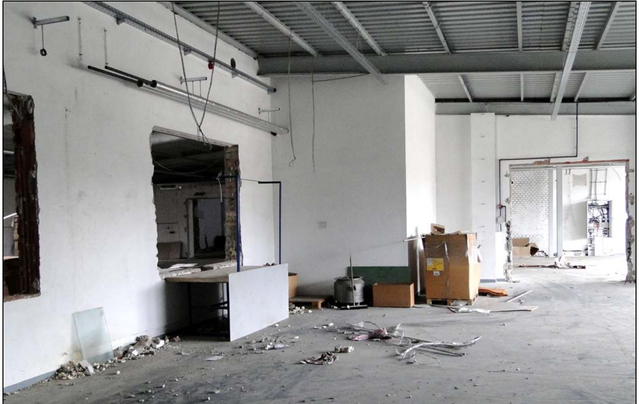
Abb. 2013-4/38-28 GLASAX: Leerräumte Mess- und Regelstation
