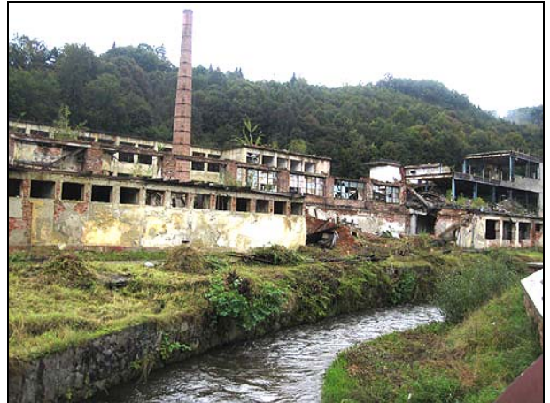
Glasfabrik „Clara“, Utekáč, um 2013
