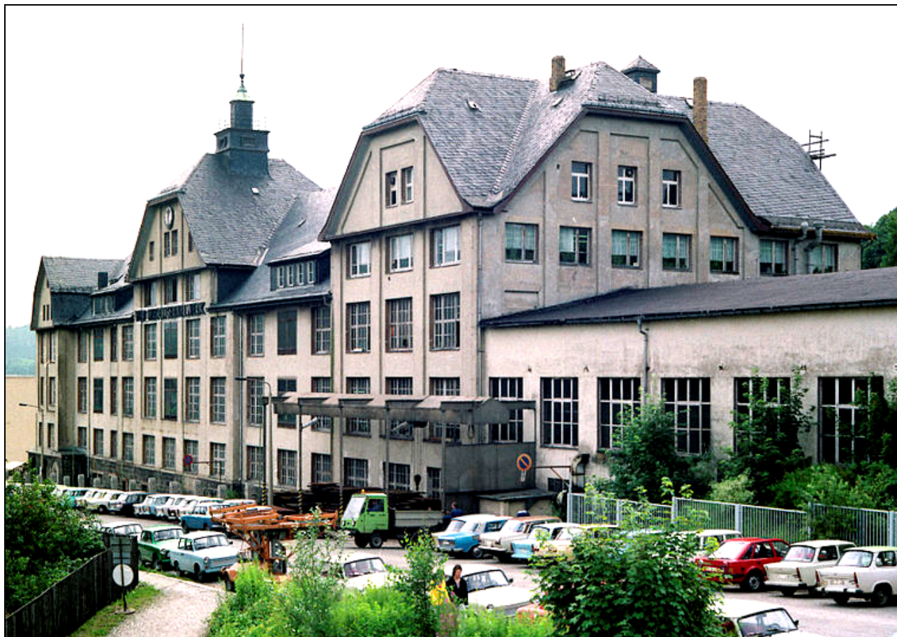
Abb. 2015-1/65-04; Haupt- und Fabrikgebäude der Fr. Wilhelm Kutzscher jun. in Schwarzenberg / Erzgebirge, zur Trabi-Zeit nach 1945 Waschgerätewerk Schwarzenberg; Werk 2 , auf dem Kutscherberg; Foto: Wunderlich, Schwarzenberg
