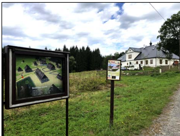
Abb. 2019/41-09 Glasmeisterhaus in České Milovy / Böhmisches Millau renoviert seit 2014, Ansicht nach Nordwesten unterhalb des Berges Čtyři Palice / Vier Schädel
