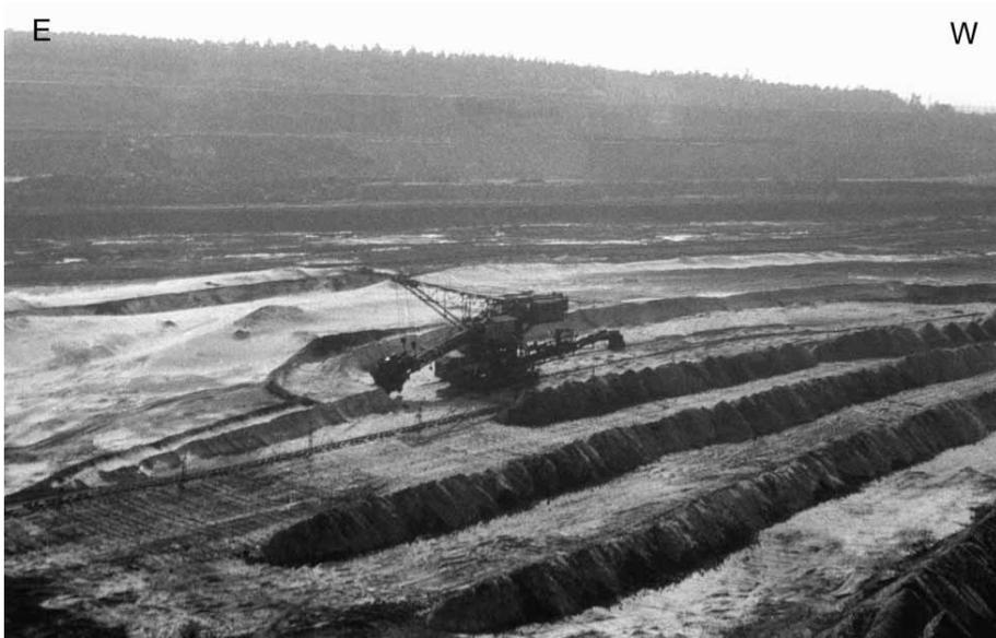
In den 70-er und 80-er Jahren sind vier Tagebaue in Betrieb. Zeitweise werden im Sonderbetrieb noch kleinere Restvorkommen abgebaut. Der Abbau konzentriert sich vorrangig auf die in den einzelnen Teilfeldern der Lagerstätte anstehenden hochwertigen Glassande. Abgebaut werden im wesentlichen nur die oberen 10 Meter
