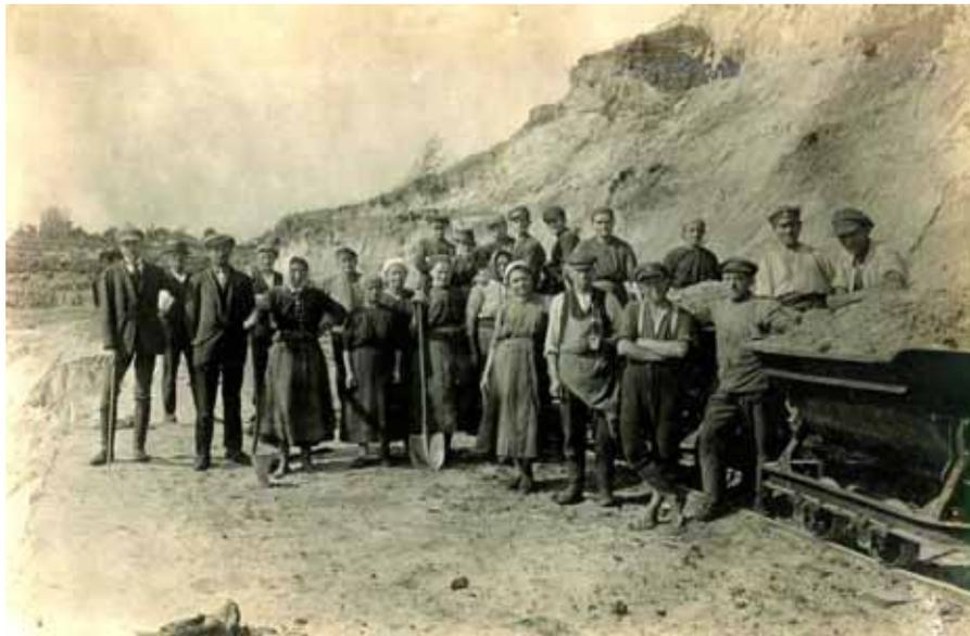
Mit dem steigenden Bedarf an Glassanden zieht auch in die Glassandgruben eine stärker mechanisierte Gewinnungstechnik ein. Um 1900 wird die Handgewinnung durch den Einsatz erster dampfgetriebener Löffelbagger abgelöst. Zur Förderung werden Muldenkipper mit Seilzugverholung eingesetzt. Später werden elektrisch angetriebene Löffel- und Eimerkettenbagger eingesetzt und
