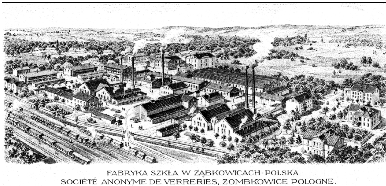
Abb. 2006-4-03/002 (Ausschnitt) (wie Abb. 2016-2-01/003, MB Zabkowie 1913 , Pressglas Bürobedarf , Vorblatt MB Zabkowie 1928 , Pressglas , Titelblatt (das Bild des Glaswerks ist identisch mit dem Vorblatt 1913 / polnisch / deutsch) "Fabryka szkła w Ząbkowicach-Polská - Société anonyme de Verreries, Zombkowie Pologne." Archiv Rona Crystal, Lednické Rovne / Sammlung Blog Zbieracz staroci
